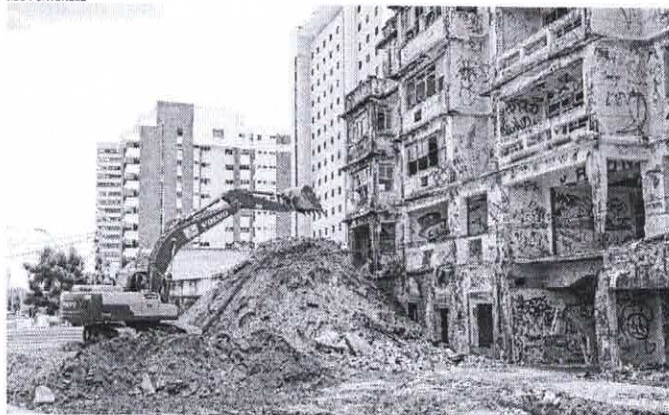
APÓS 12 dias de embargo, a obra de demolição do São Pedro recomeçará
