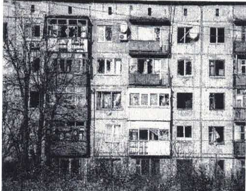
PREDIO residencial danificado em Severks, região de Donetsk, em meio à invasão russa da Ucrânia
